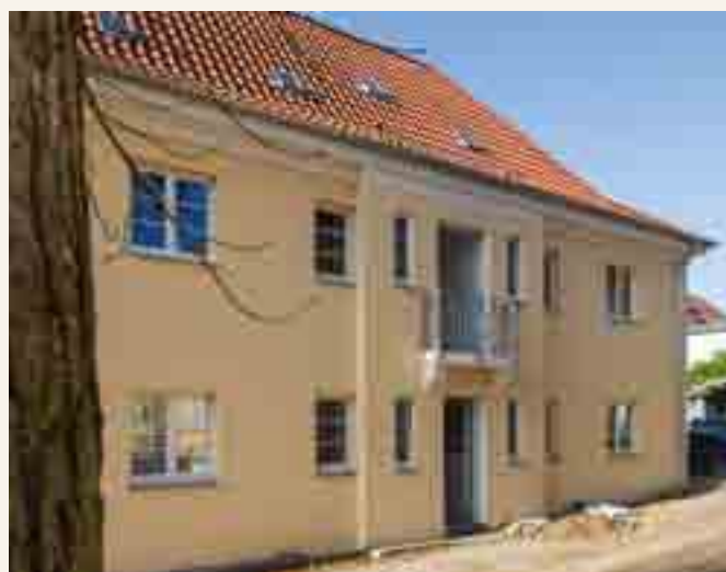
... und Ansicht nach den aktuellen Sanierungsarbeiten und mit den neuen Sprossenfenstern.
