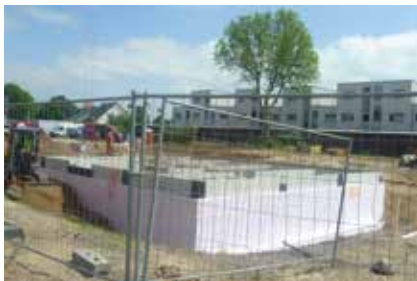
Erste Bauarbeiten im Juni
