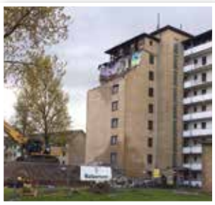
Nach dem Abriss...
