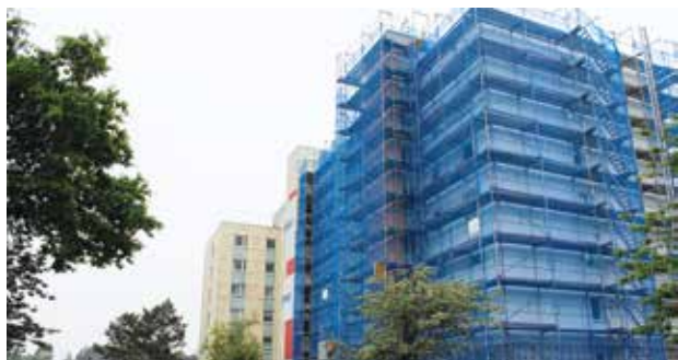
Wärmedämmung für Häuser im Timm-Kröger-Weg
