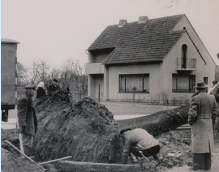
Bauarbeiten in Fruerlund
